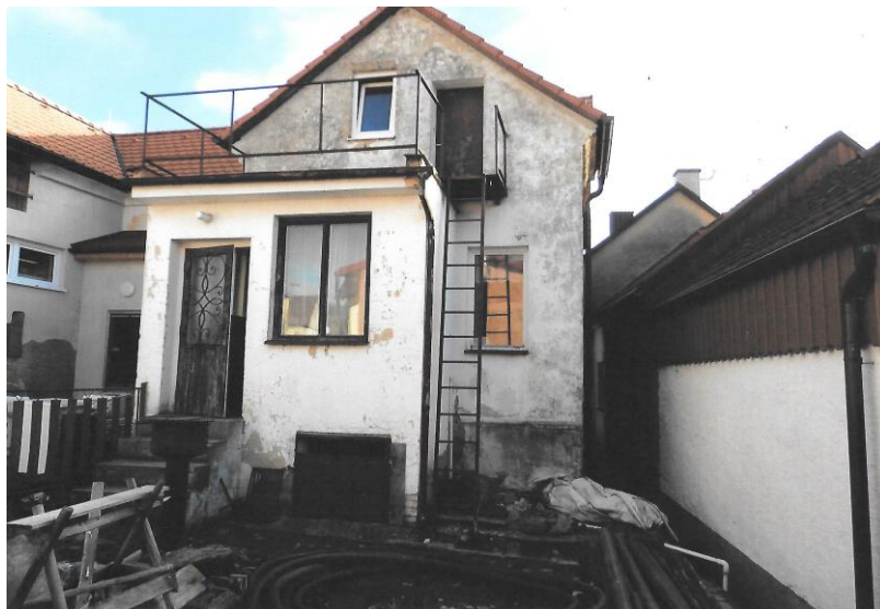
Budova č. ev. 1 před zahájením stavebních prací
